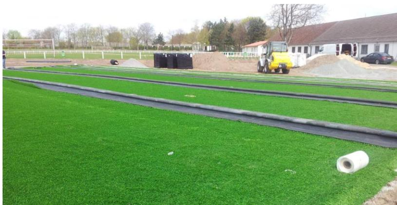
**Figura 4:** Desenrollar el recubrimiento de césped artificial
