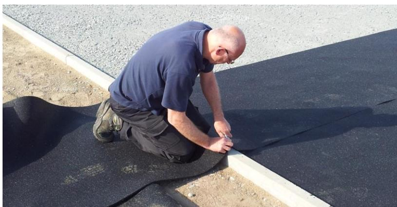
**Figura 3:** Cortar el saliente del recubrimiento elástico
