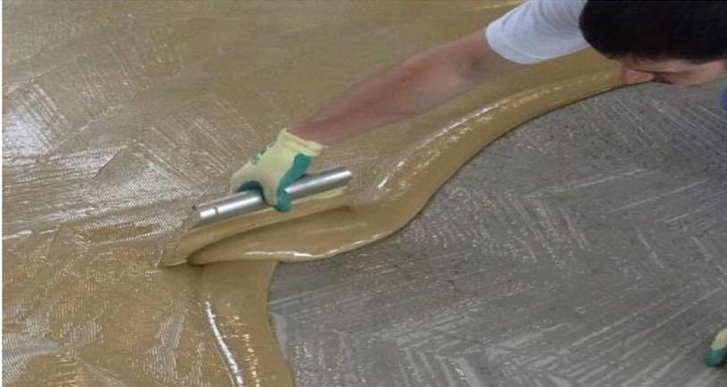
**Figura 2:** Aplicación del pegamento sobre la base
